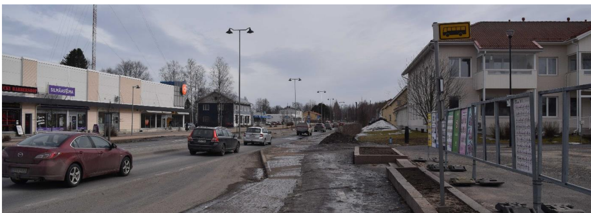
Kuv4a8 Muhoksen taajamassa rakentaminen valkautuu eteenä nähtävään katualueeseen suuntaan.
