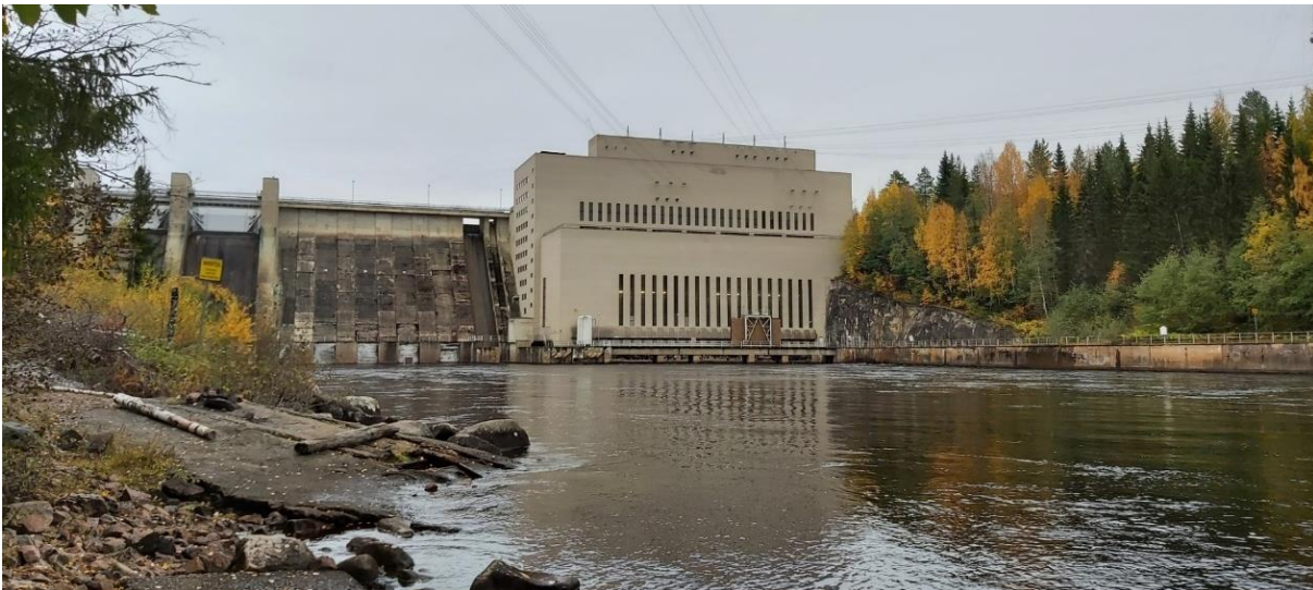
Kuva 5a4 Pyhäkosken voimalaitos.
