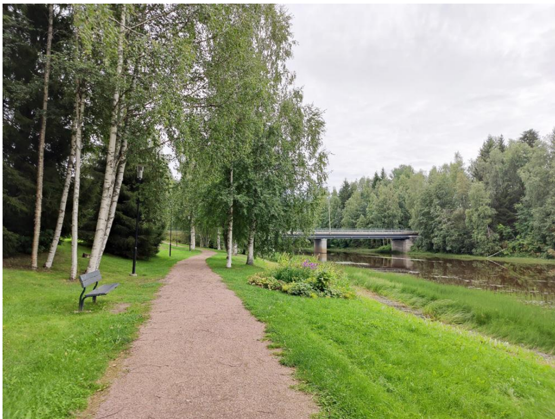
Kuva 5. Muhosjoen rantaa luoteesta päin katsottuna. Taustalla näkyy joen ylittävä silta Leppiniementien kohdalla (Lukkaroinen Arkkitehdit Oy, 08/2023).
