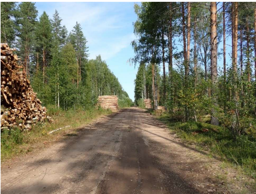
Kuva 10. Repokankaantie. Vanhan rautatienpohjaa alueen itäosassa. Pohjoiseen.
