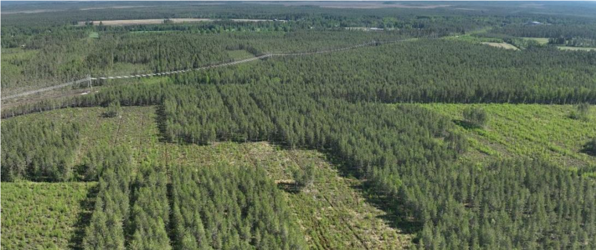
Kuva 35. Ilmakuva suunnittelualueen itäosasta. Metsäalueilla erottuu avoimia hakkuuaukeita. Kuvassa näkyy Pällin voimalaitokselle johtava voimajohto. (Kuva: Muhoksen kunta/Hannu Leskelä, 2024)
