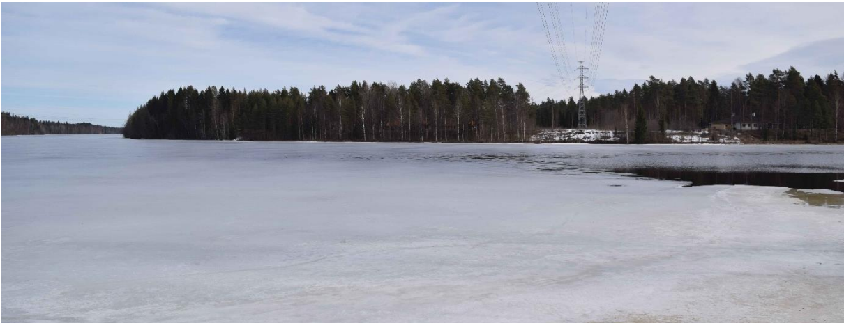
Kuva 40. Näkymä Pyhäkosken voimalaitoksen patosillalta itään suunnittelualueen suuntaan.
