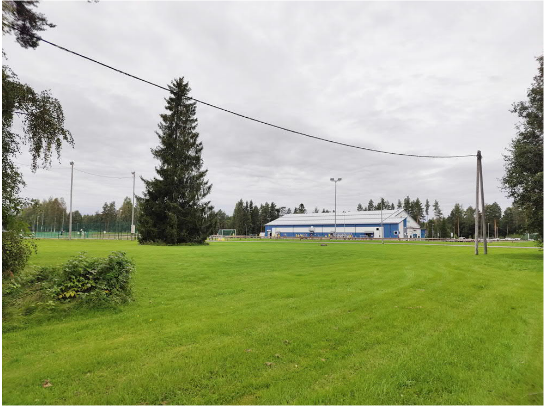
Kuva 9. Muhoksen jäähalli ympäristöineen kaakosta katsottuna (Lukkaroinen Arkkitehdit Oy, 08/2023).
